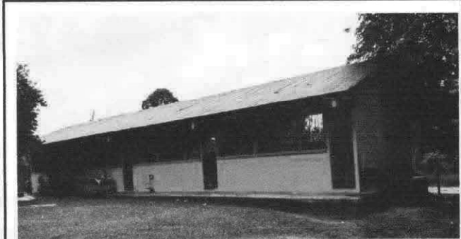
Foto7: Instalación de lámina troquelada Aluzinc calibre 26.
