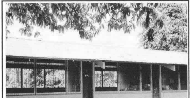
Foto 4: Sustitución de capotes de lámina para lámina troquelada Aluzin calibre 26.
