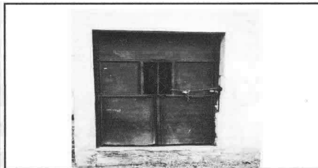
Foto 5: Mantenimeinto a puertas de metal.
